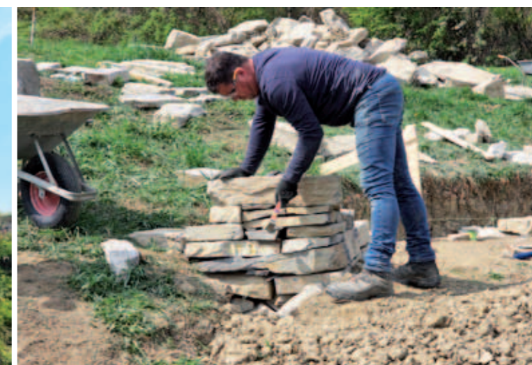
In mühevoller Handarbeit entsteht eine Trockensteinmauer.
