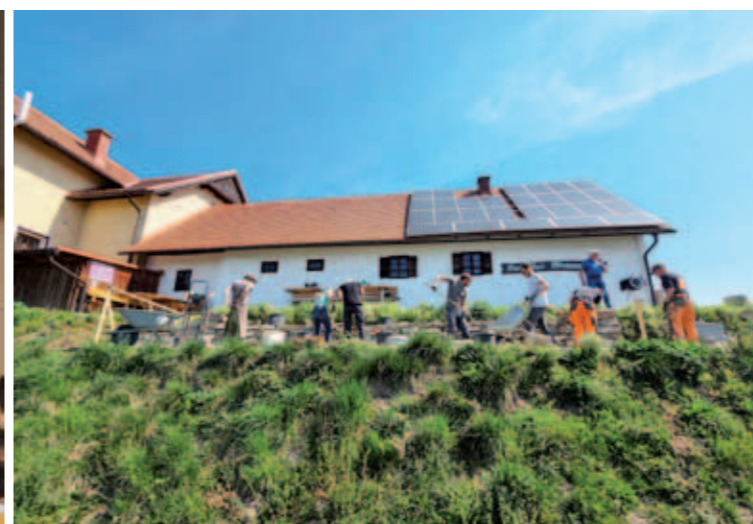
Beim Weinbaumuseum in Kitzreck wird eine Trockensteinmauer errichtet.
