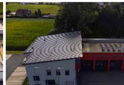
Rüsthause in Straß in Steiermark: 6,39 kWp Modulleistung, 16,56 kWh Speicher
