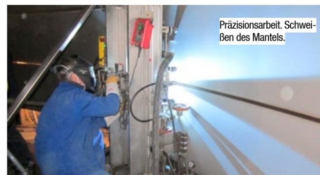
Präzisionsarbeit. Schweißen des Mantels.
