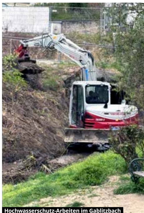
Hochwasserschutz-Arbeiten im Gablitzbach
