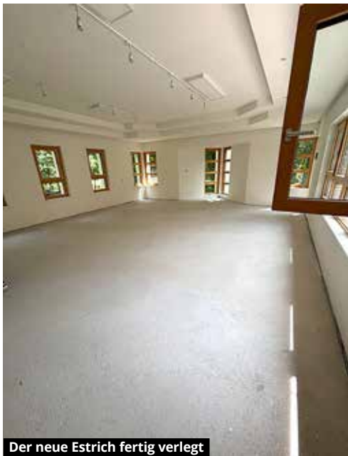
Der neue Estrich fertig verlegt
