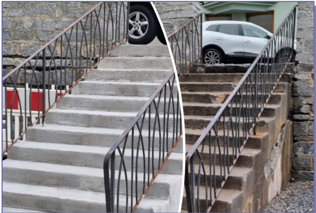
OBEN: sanierte Treppe Kirche/Friedhof (Bild: M.Zangerl)
