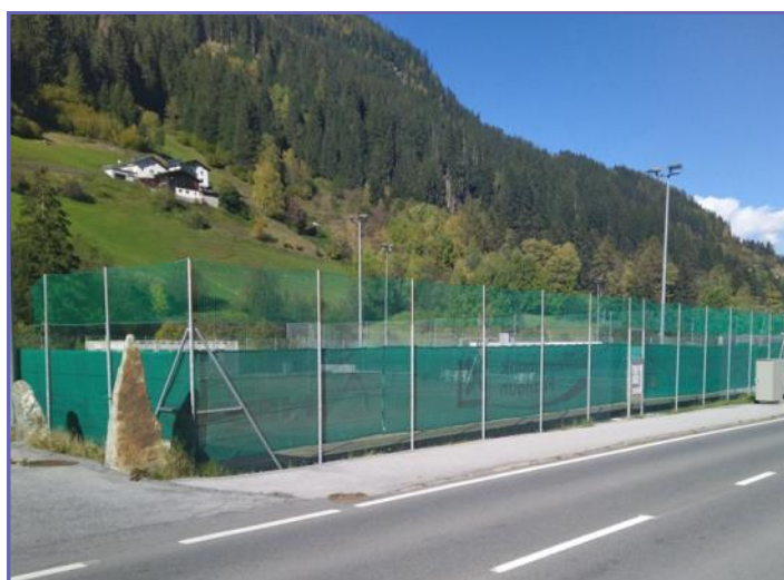
Die Zaunanlage wurde 2020 straßenseitig um 1 Meter aufgestockt. (Bilder: TC See)
