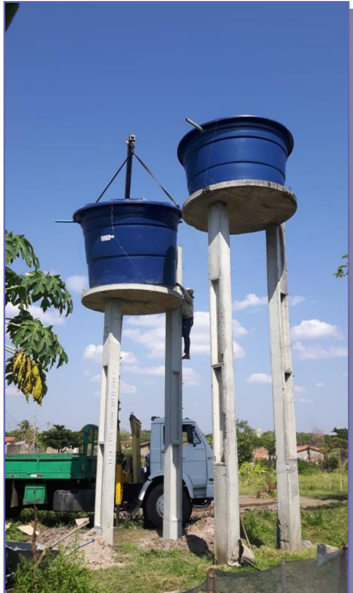
3 Brunnen mit Wasserspeicher in 6 Metern Höhe konnten errichtet werden
