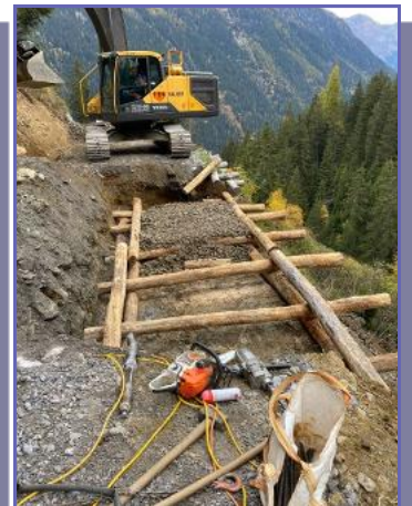
OBEN: Schallerbach Mittellauf - 3 von insgesamt 10 Sperren sind fertig (Bild: R. Juen) UNTEN: Entwässerungsmaßnahmen PIFANG, Krainerwand Löchereggweg (Bild: P. Siegele)
