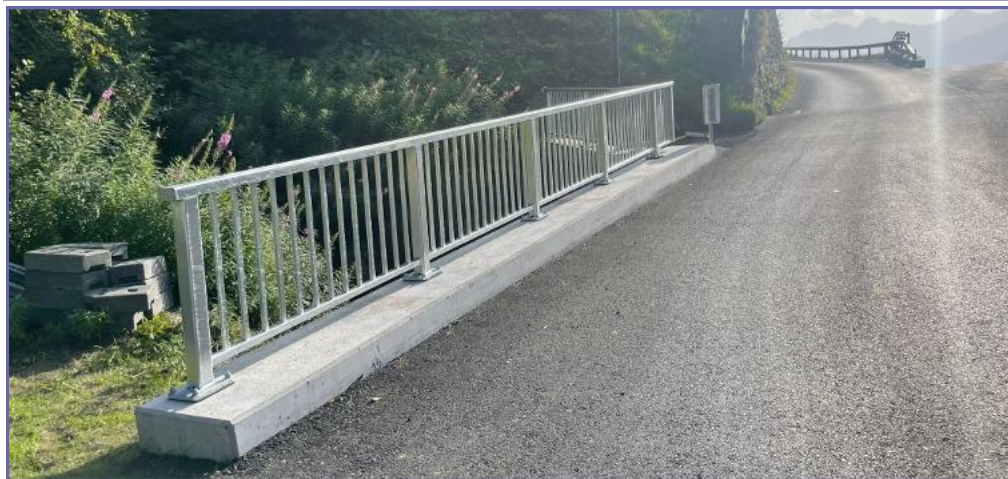
Sanierte Brücke Pillmahd (Bild: B. Spiss)
