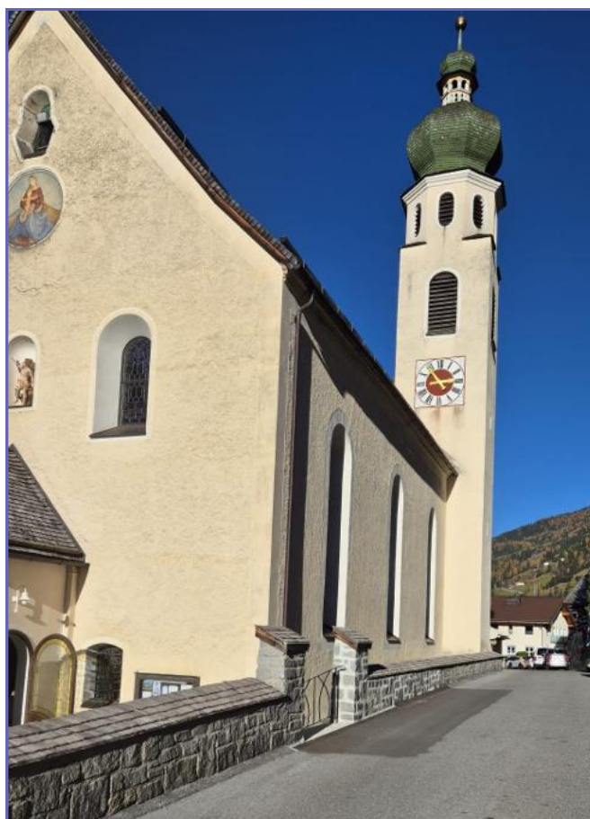
Sanierung Friedhofsmauer (Bild: M. Zangerl)
