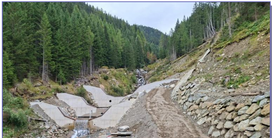
OBEN: Schallerbach Mittellauf - 3 von insgesamt 10 Sperren sind fertig (Bild: R. Juen) UNTEN: Entwässerungsmaßnahmen PIFANG, Krainerwand Löchereggweg (Bild: P. Siegele)
