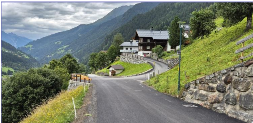
Sanierte Straßenabschnitte (Bild: M. Zangerl)
