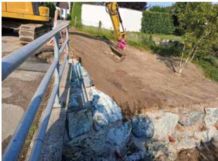
Ufersicherung bei der Brücke – Höhe Kulturzentrum
