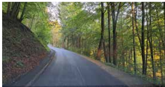
Die Sanierung im Heumanngraben erfolgte binnen sechs Wochen
