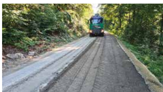
Auf einer Gesamtlänge von rund 1200 Metern wurde die Pfannbergstraße erneuert
