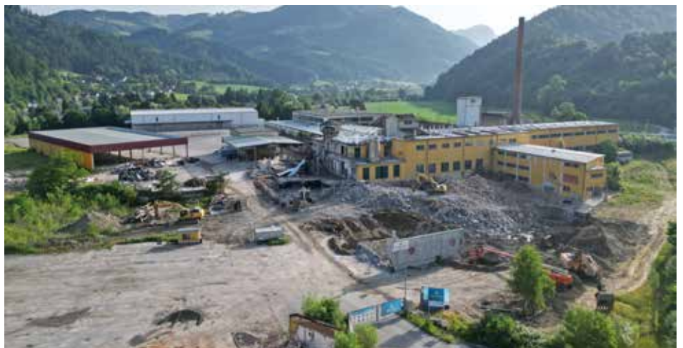
Die Abbrucharbeiten der alten Industrieanlage sind bereits im Gange
