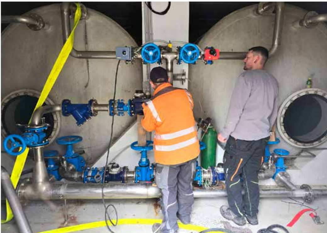
Beim Hochbehälter in Rothgmos wurde vom Leitungseingang bis zu den Behältern eine permanente Edelstahlverbindung zur Befüllung bei Notfällen hergestellt.
