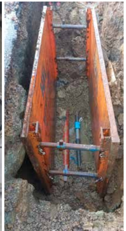
Sanierung Rohrbruch
