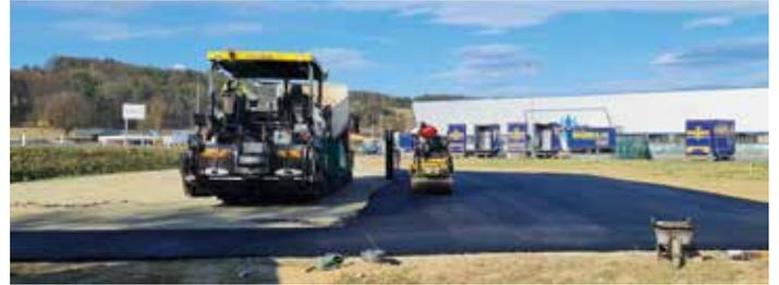
Lastwagenparkplatz, direkt neben der Landesstraße errichtet. Die Bauarbeiten sind bis auf die Markierung der Stellplätze bereits abgeschlossen.
