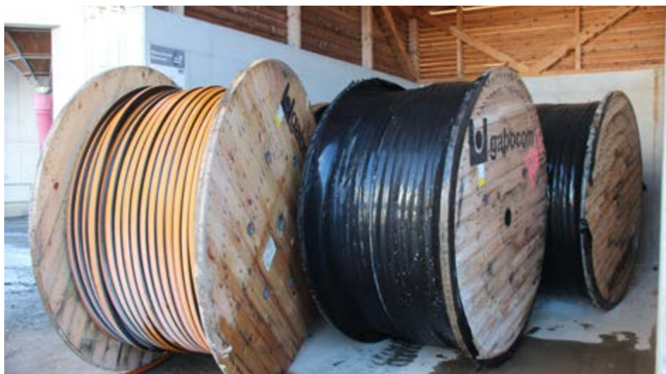
Rund 6.500 lfm Microrohre stehen bereits im Bauhof zur Verlegung bereit.
