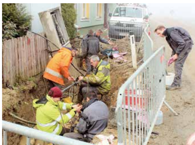
Um den Betriebsausfall möglichst kurz zu halten, waren bei den Spleißarbeiten beim ARU Gersdorf sieben Techniker der A1-Telekom gleichzeitig im Einsatz.
