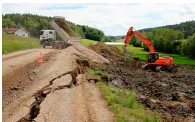
Sanierung der tiefgründigen Rutschung im Bereich Loder/Haider in Gschmaier.
