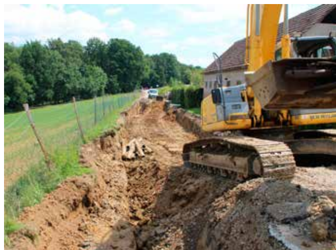
Eine neue Verbandsleitung musste auch bei der Rutschung im Bereich Fritz/Oberschmaier verlegt werden.
