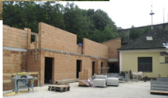
Flotter Baufortschritt am neuen Feuerwehrhaus
