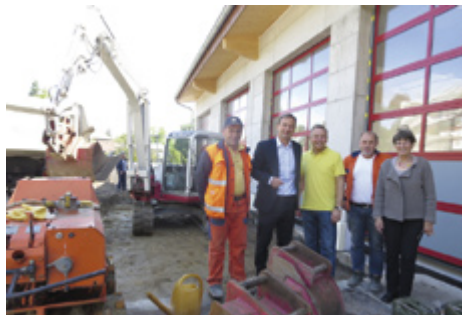
Vorplatz vor der Feuerwehr: Start der Asphaltierung. (v.li.: Enver Morina, Martin Michalitsch, Gerhard Svatek, Michael Grünsteidl, Hedi Thun).
