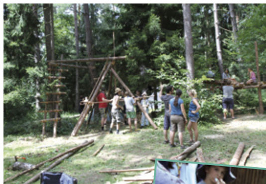
Bau der Turmplattformen
