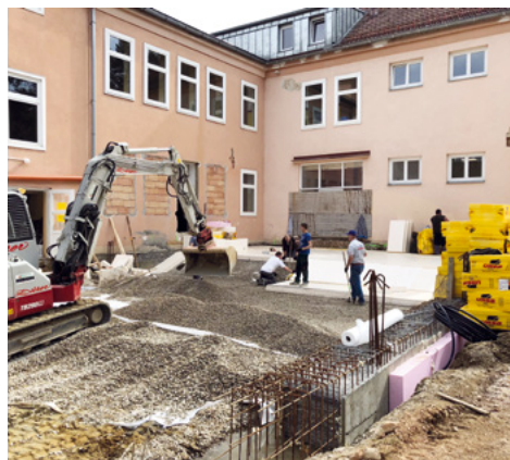
Baustelle Schule April 2018
