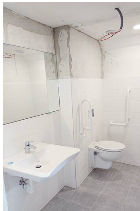
Das Behinderten-WC ist fast fertig.
