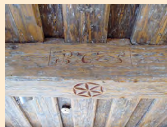
Die Balkendecke von 1725 stammt von einem Abrisshaus.
