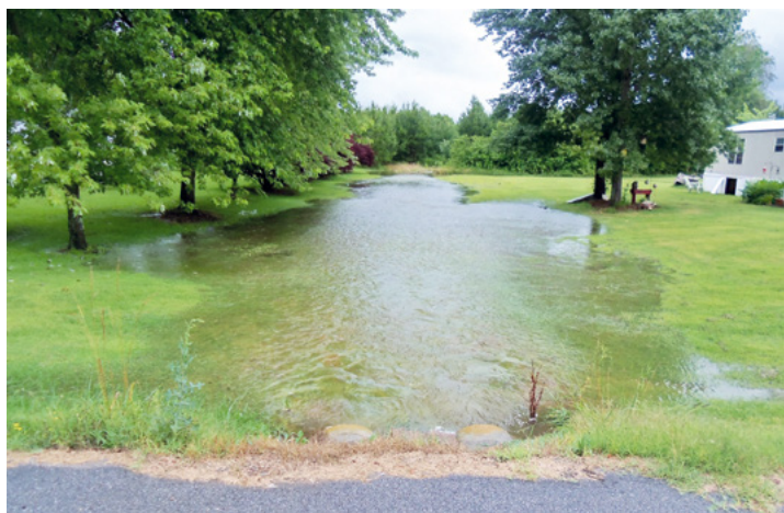
Auswirkungen von Starkniederschlag
