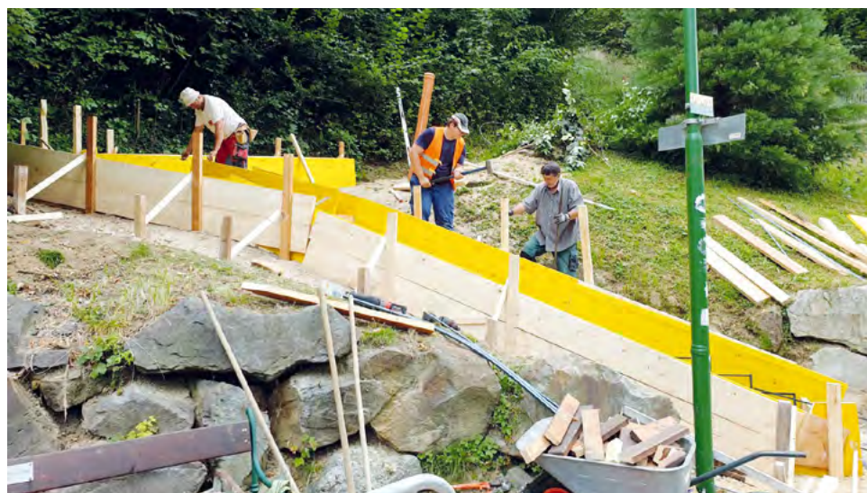
Die Sanierungsarbeiten am Gartensteig schreiten voran.
