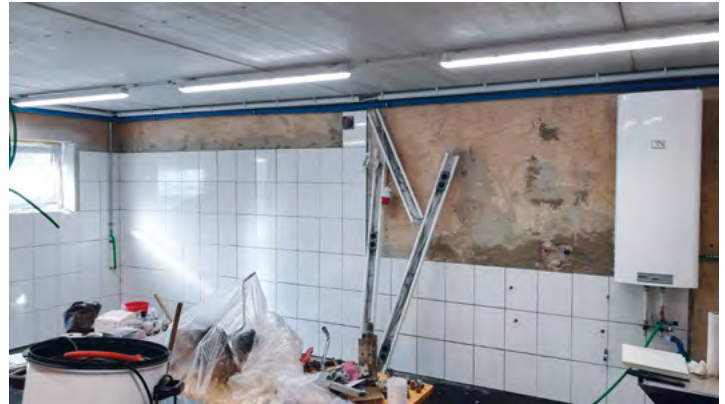
Verfliesen im Keller
