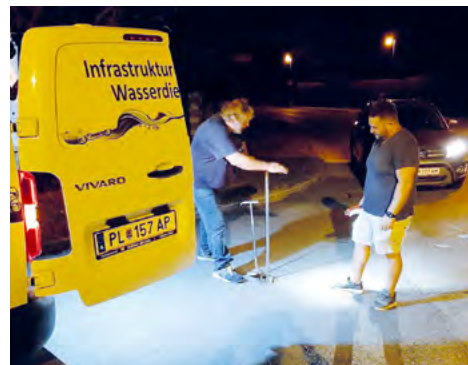
Nächtliche Suche nach der Leckage
