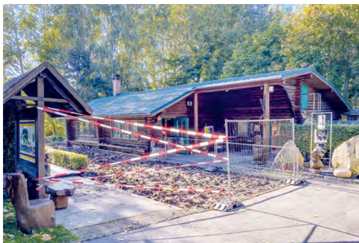
Erdarbeiten zwischen Kegelhütte und Kegelbahn
