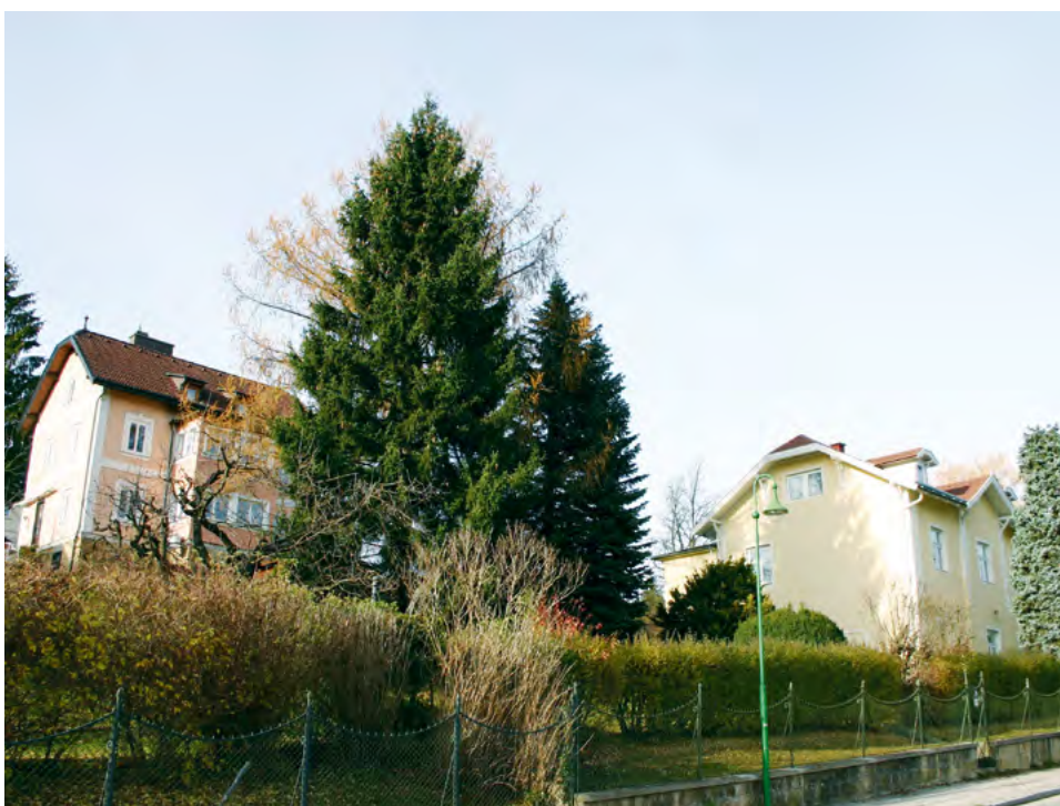
Villen an der Bahnstraße
