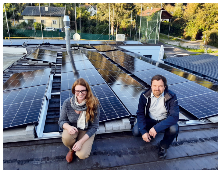
Der neueste Errungenschaft des Wienerwaldbades: Die PV-Anlage senkt die Energiekosten!
