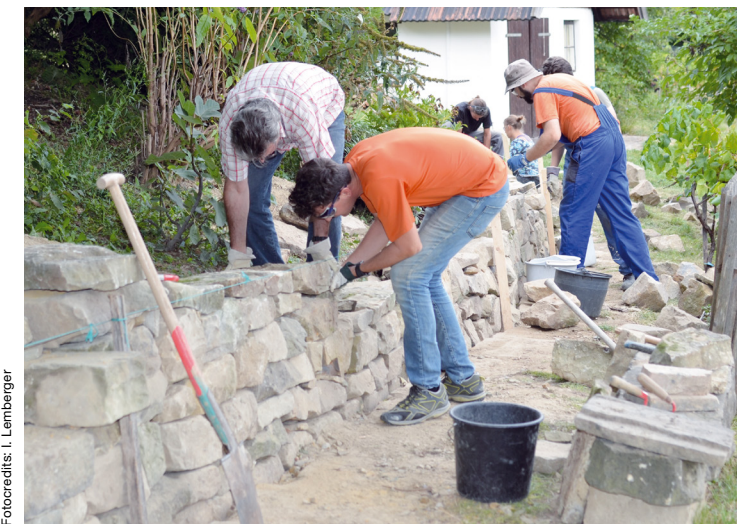
Die Trockenmauer wird gesetzt, Stein für Stein.
