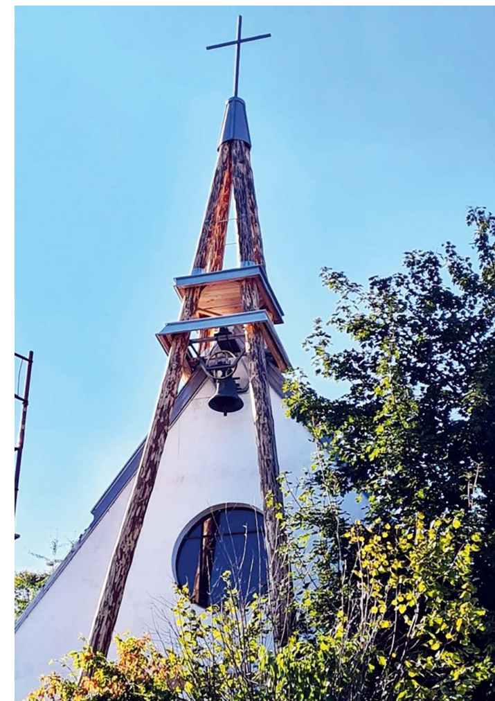
Der Glockenturm erstrahlt in neuem Glanz
