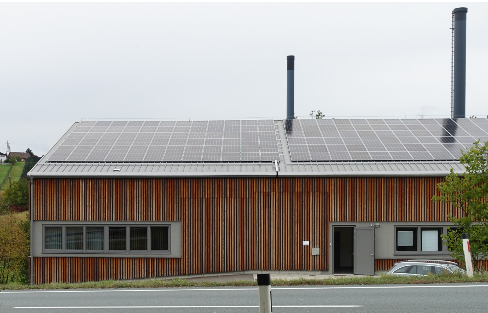
Integration von PV Modulen in die Dachfläche
