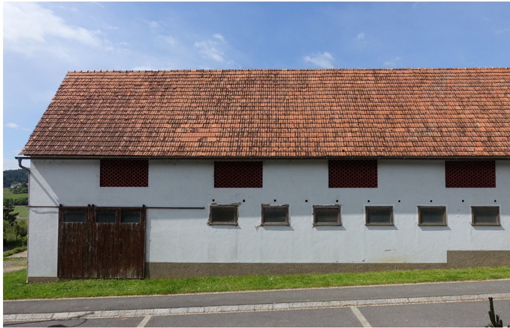
Unterschiedliche, der Nutzung entsprechende Fassadenöffnungen bei traditionellen Wirtschaftsgebäuden gliedern große Wandflächen
