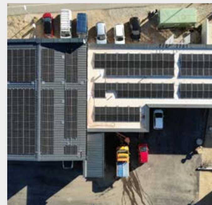
150 kWp stark ist die PV-Anlage am Trofaiacher Bauhof. Interessierte Stromkund:innen der Stadtwerke Trofaiach könnten sich noch daran beteiligen und Erträge sichern.
