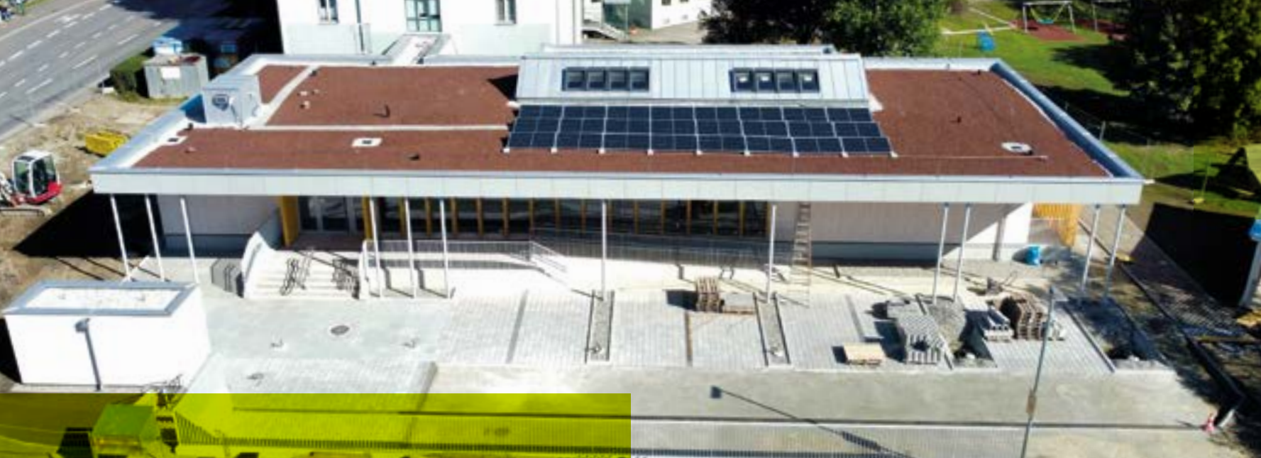
Die Kinderkrippe Pustebume ist kurz vor der Fertigstellung.
