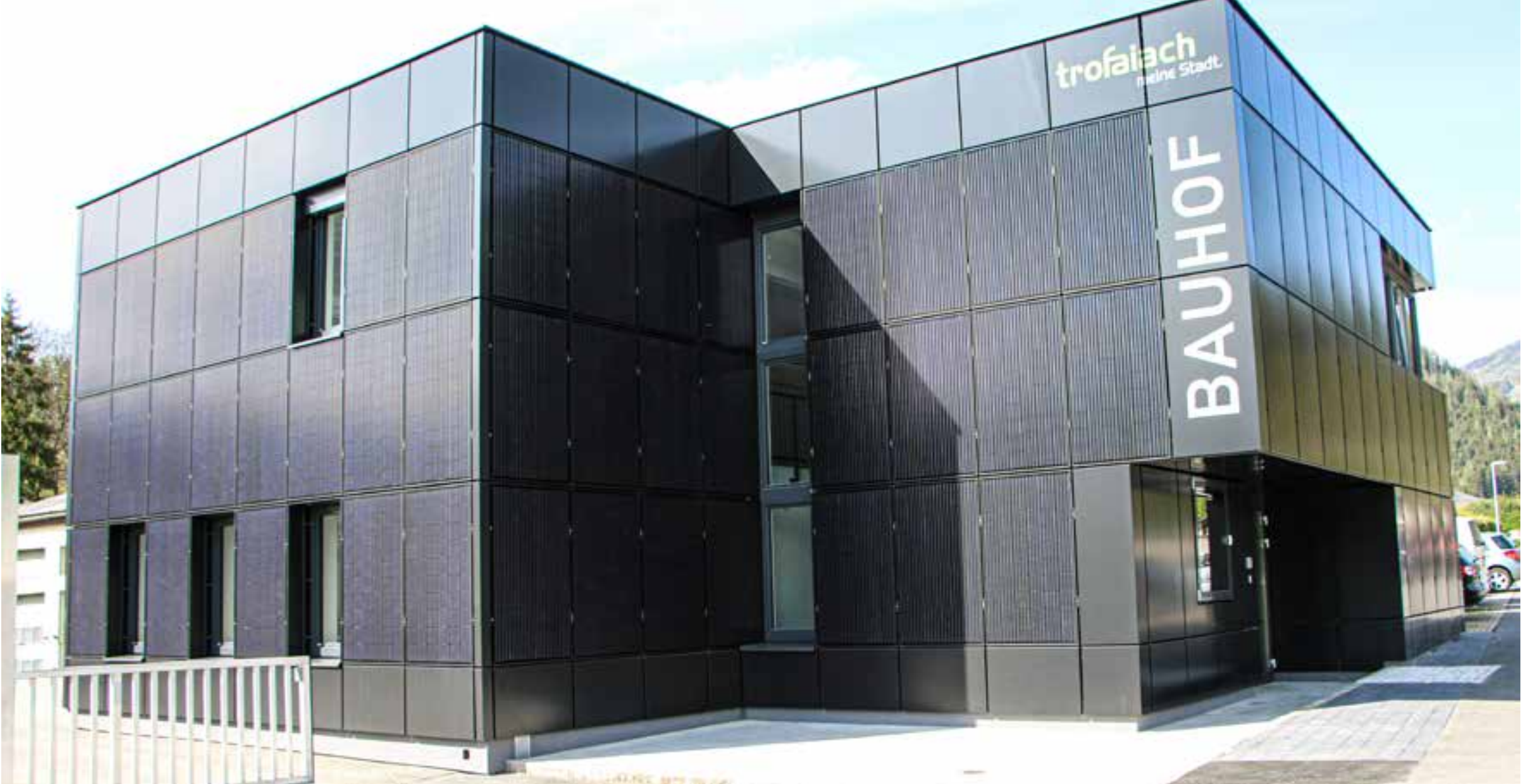
Die PV-Außenfassade am Betriebsgebäude des städtischen Bauhofs.
