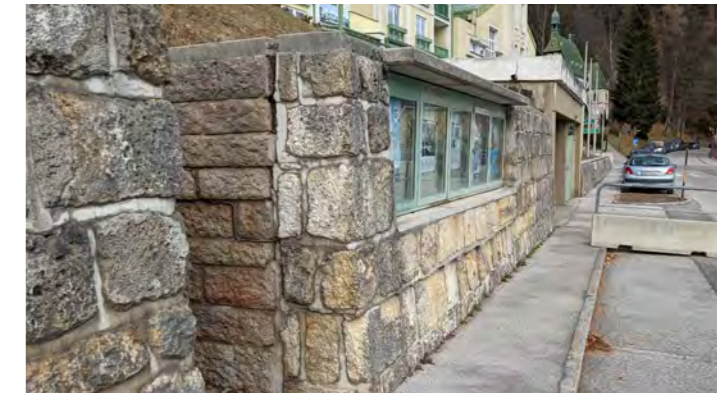
Sanierung der bergseitigen Stützmauer unterhalb des Apartmenthauses Hochstraße Nr. 38.
