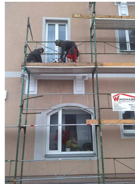
Arbeiten an der Balkonsanierung am Gemeindeamt durch die Firma Windhaber
