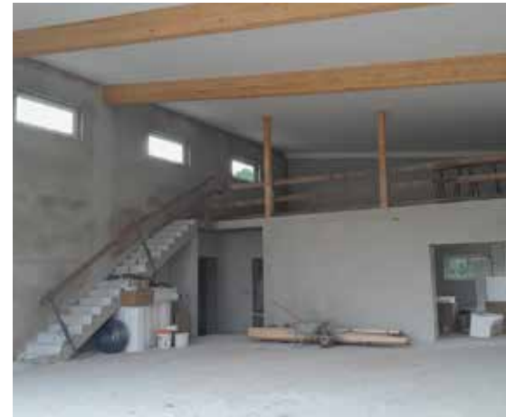
Status-Quo. Derzeit laufen die Arbeiten im Inneren des Neubaus auf Hochtouren.
