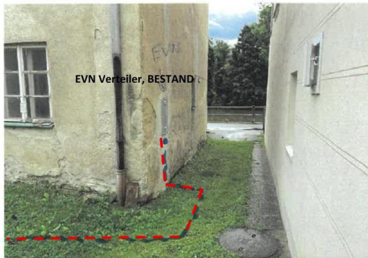
Aufputz oder eingestempte Leitung = Anschluss an Bestandsleitung
