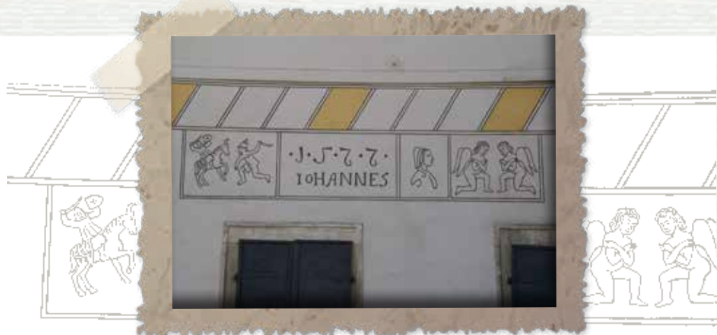
Detail am alten Museum in der Wiener Straße aus dem Jahr 1577 eines der wenigen Renaissance-Elemente in Waidhofen.
