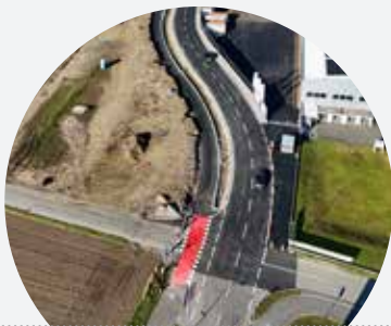
Verlängerung Thayaparkstraße mit Begleit-Radweg
