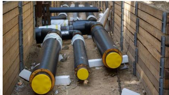
Auch Oberaudorf will die Wärmenetze ausbauen. Hier werden Rohre für Fernwärme-Anschluss werden unterirdisch verlegt (Symbolbild). © picture alliance/dpa
