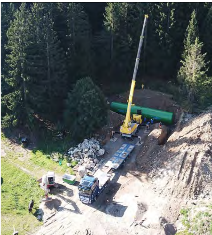
Neuer Trinkwasserhochbehälter Grafenherberg wird geliefert
