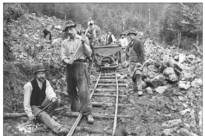
Arbeiter beim Bau der Wendelsteinbahn (Foto um 1911, Archiv der Wendelsteinbahn GmbH, Brannenburg)
