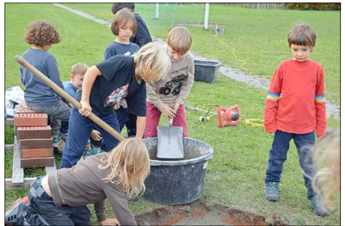
Unterstufenkinder errichten eine Feuerstelle für die Schule
