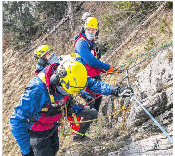
Arbeiten am Seilgeländer
