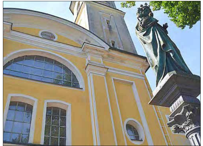
Abgebaut das Schutzgerüst am Eingang zur Klosterkirche Reisach. Ein neues Schutzgerüst soll für Sicherheit sorgen. Foto: Lotter
