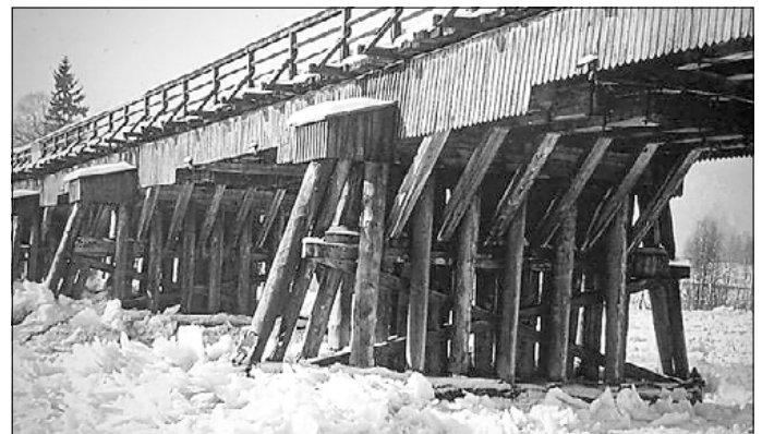
Mächtige Eisschollen beschädigten im Jahre 1985 die Brückenpfeiler
