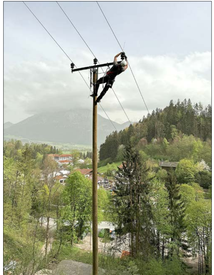
20 kV-Freileitungsreparatur „Am Hals“
