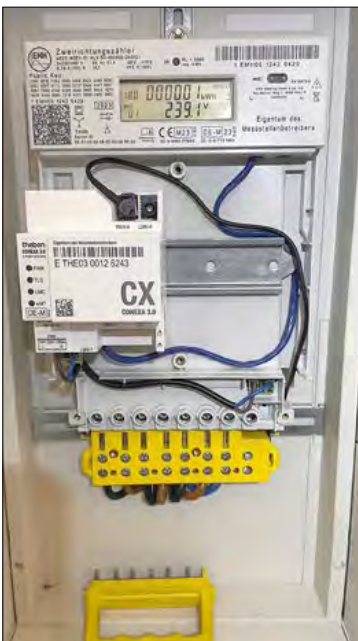
iMSys mit Zählersteckklemme (gelb)
