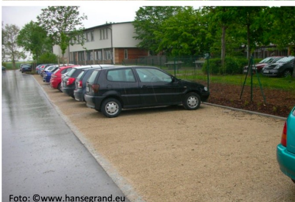
Abbildung 44: wasserdurchlässige Oberflächenbefestigungen sind in der Lage, Niederschläge aufzunehmen, zu puffern und zu versickern; gleichzeitig wird der Anteil an versiegelten Flächen reduziert.
