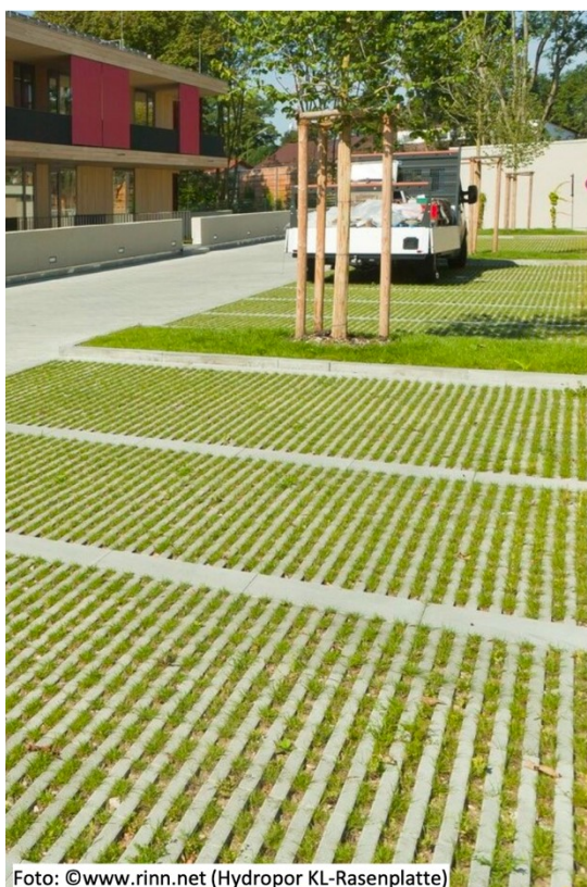
Abbildung 44: wasserdurchlässige Oberflächenbefestigungen sind in der Lage, Niederschläge aufzunehmen, zu puffern und zu versickern; gleichzeitig wird der Anteil an versiegelten Flächen reduziert.
