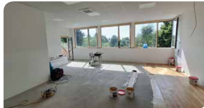
Umbau der Volksschule – aus dem Medienraum werden 2 Klassenzimmer
