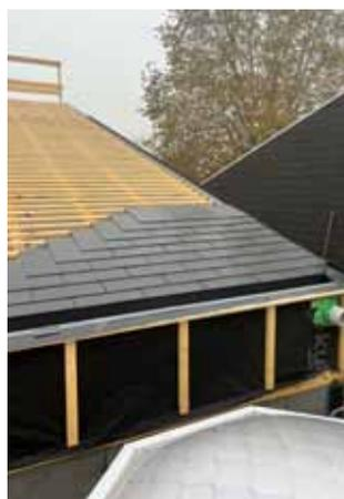
Fassaden und Dächer werden mit Faserzementplatten gedeckt. So wird die Fassadengestaltung der bestehenden Volksschule nahtlos fortgesetzt.
